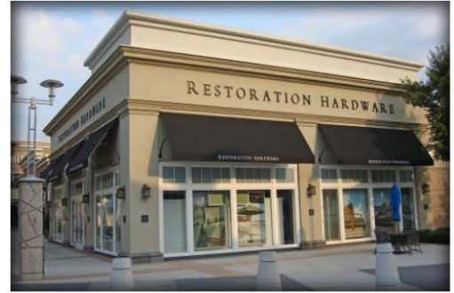
EIFS CORNICE/CLOTH AWNINGS
